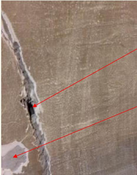
1.对开裂严重的缺陷，采用铲刀剔除裂纹上的涂层，并把裂纹打开。
